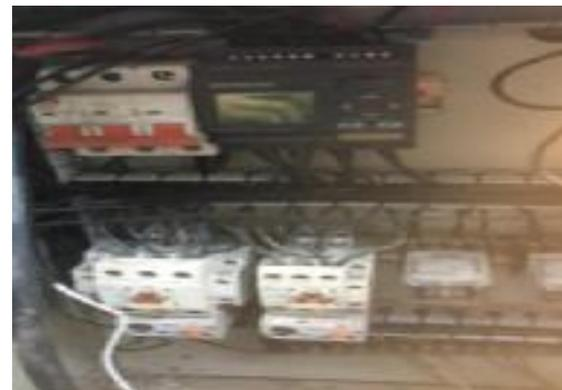
**Mantenimiento correctivo de la cámara frigorífica (Cambio de filtros, sondas, refrigerante, controlador electrónico,, resistencias, contactores, protectores térmicos, focos leds, ventiladores del evaporador, presostato de alta y baja, leds pilotos, cable concéntrico, remaches, autoperforantes).**
