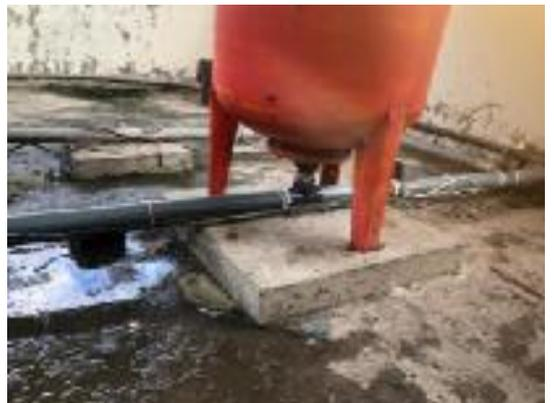
**Mantenimiento correctivo e instalación de bomba trifásica 220/440vac, multietapas de alta revolución para el caldero, accesorios de tubería, anclaje, modificación de tablero de control a trifásico 220VAC.**
